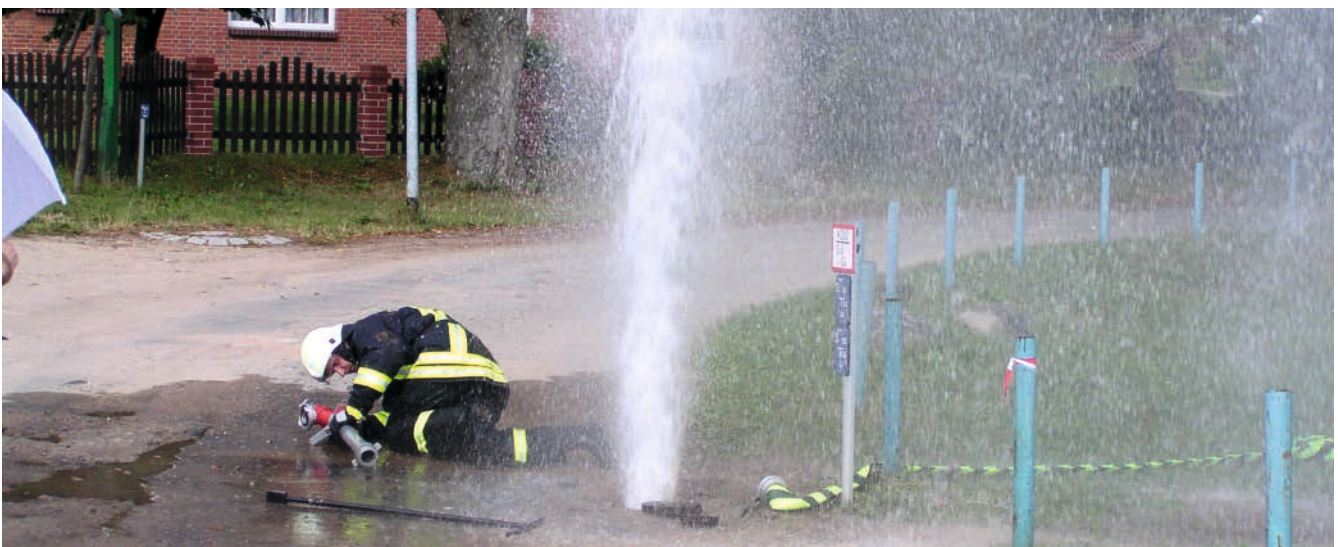
► Kleine Ursache – große Wirkung, wie hier, wenn das Standrohr entfernt wird, ohne vorher den Hydranten abzuschließen.
