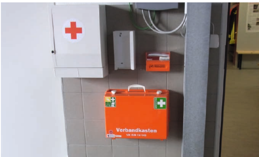
► Das Erste-Hilfe-Material ist gut sichtbar und erreichbar in der Fahrzeughalle angebracht. Darüber befindet sich ein Pflasterspender.
