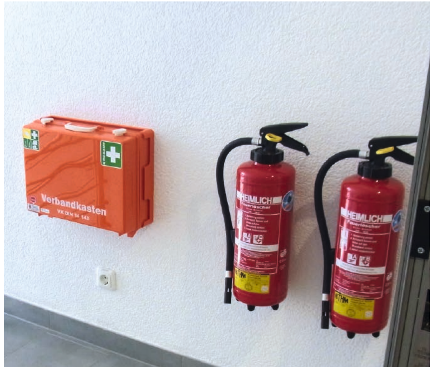
► Ein zusätzlicher Verbandkasten im Obergeschoss, in dem sich der Schulungsraum und die Küche befinden.
