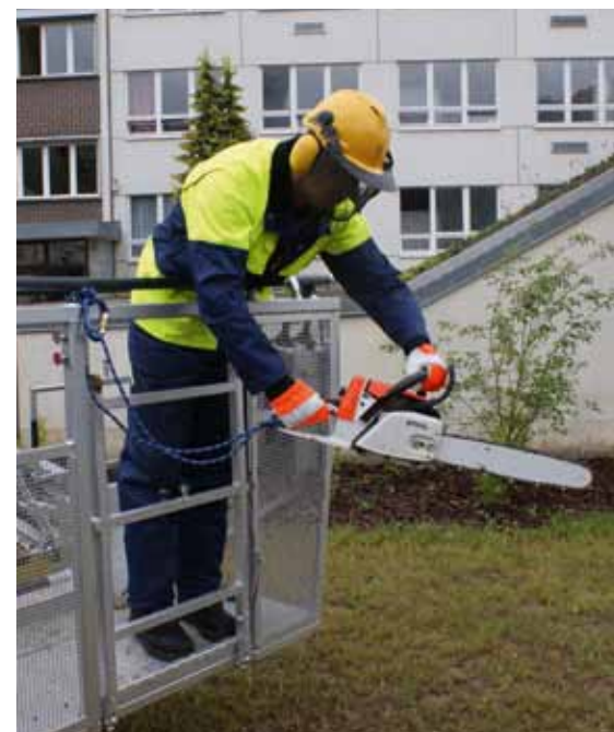
Einsatz der Motorsäge vom Korb einer Drehleiter aus
