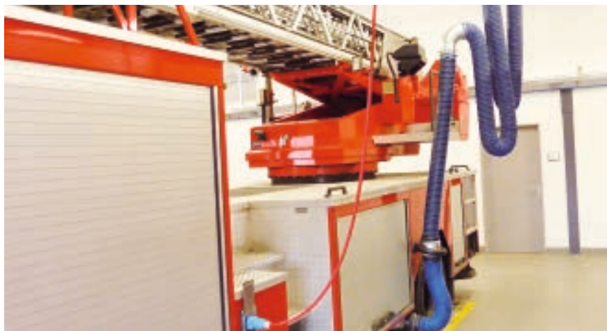
» Abgasabsaugung an einem Feuerwehrfahrzeug
