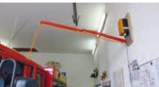
► Positivbeispiel: Ladekabel stellt keine Behinderung dar.
