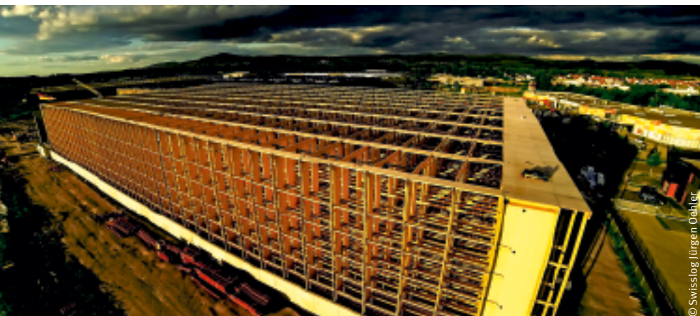
Hochregallager im Bau
