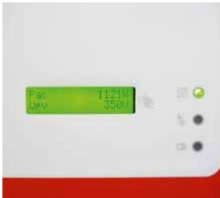
Steuerungseinheit einer PV-Anlage mit Anzeige der momentan produzierten Gleichspannung
