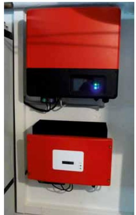
Sogenannter DC-Freischnalter an der Steuerungseinheit der PV-Anlage
