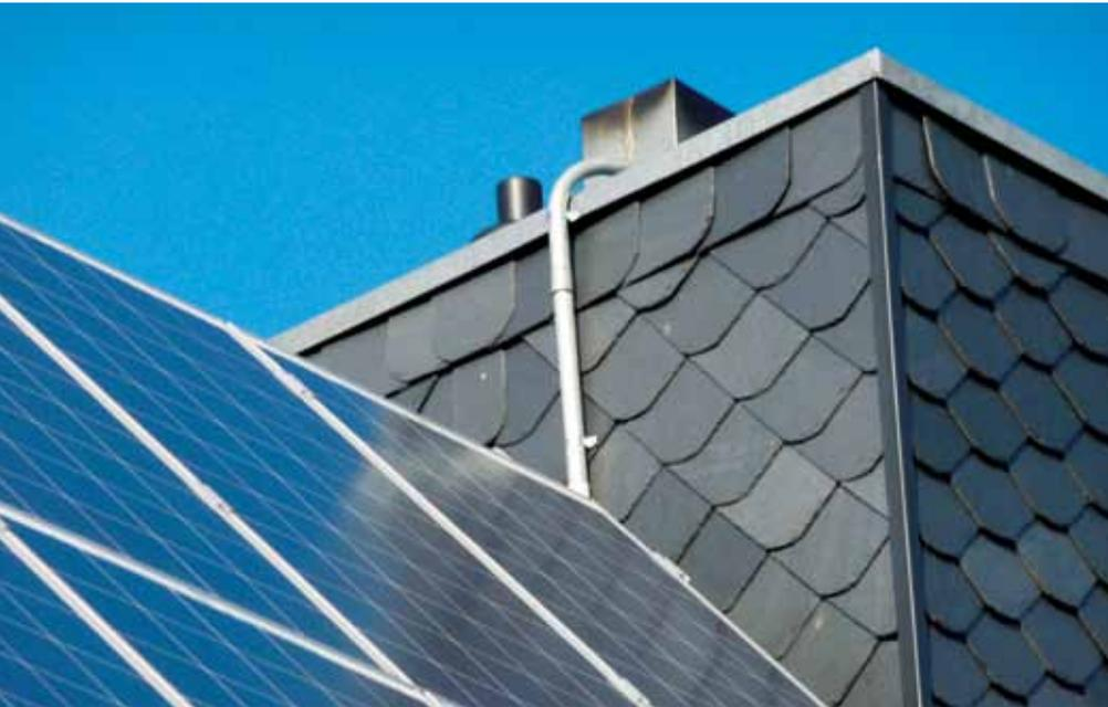
Kabel, welches den Gleichstrom vom Photovoltaik-Modul zu einem Wechselrichter ableitet. Es herrscht eine Gleichspannung von bis zu 1.000 Volt.
